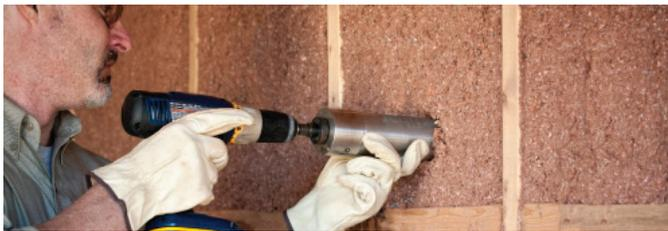
5. Las muestras de humedad deben tomarse en la mitad de la cavidad, teniendo en cuenta que se debe seleccionar un área donde se pueda tomar una muestra de 8 pulgadas de profundidad.
