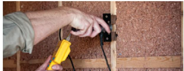
6. El contratista instalador es responsable de realizar las pruebas de campo de densidad y contenido de humedad. El contratista instalador debe proporcionar al constructor una copia de los resultados de las pruebas de campo en el Registro de Pruebas de Campo de Muros Contra Incendios de UL, o equivalente, para cada unidad instalada.
